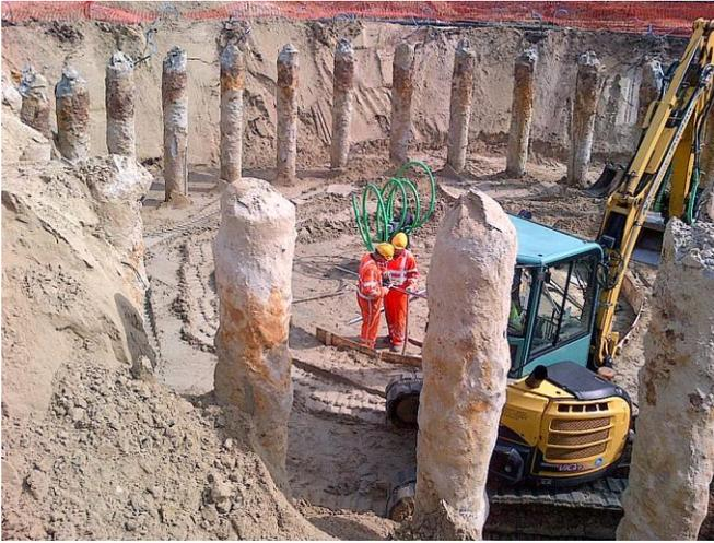
Creusement du puits de chantier et les pieux de fondation sur le site de GENK
