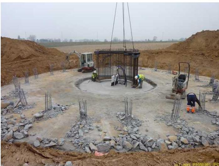
Mise en place de la cage d'ancrage sur le site de WUUSTWEZEL
